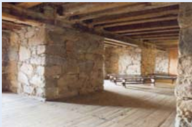
Förläggingsvalv under huvudvallen
